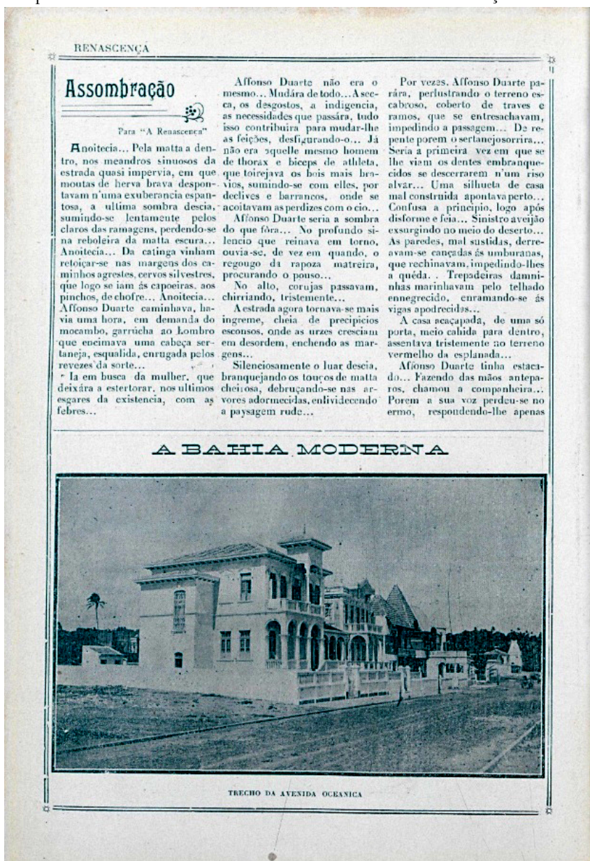
Figura 7 – No rodapé da página, clichê da série A Bahia Moderna , apresentando um palacete recém-construído na Avenida Oceânica em construção
